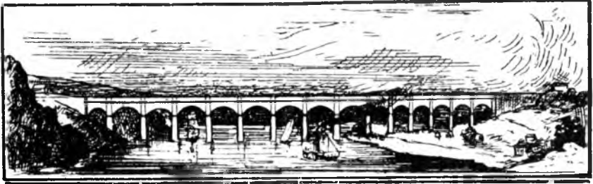
Водопроводный мост высотой в 45 метров. (Водоснабжение Нью-Йорка).
